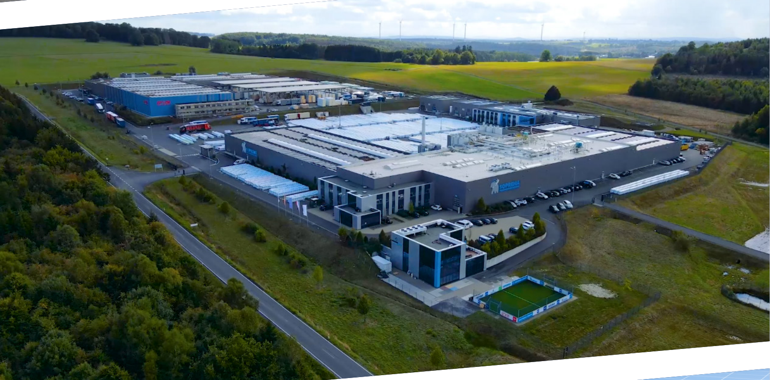
Usine de Hof (Allemagne) © SOPREMA
